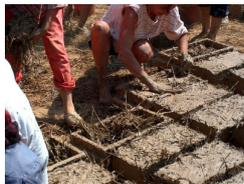
Certe volte, per evitare che si secchino, i mattoni vengono avvolti in uno straccio umido. Con questi mattoni si costruiscono i muri di fango che mantengono il calore in inverno ed il fresco in estate. I muri possono rovinarsi con la pioggia, ma basta intervenire con dell’altro fango e tutti si risistema.”
